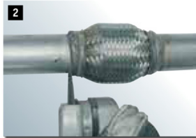
An der gekennzeichneten Stelle (hinter der Schweißnaht) altes Flexrohr mit der Flex abtrennen.
