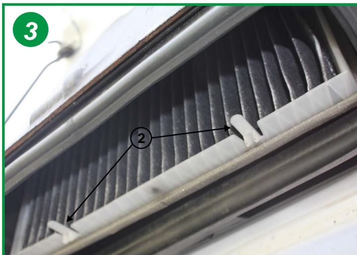
Extraire l'élément filtrant usagé en le soulevant à l'aide des 2 pattes (2). A l'arrière du filtre se trouve un picot de centrage qu'il faudra utiliser pour replacer le nouveau filtre.
